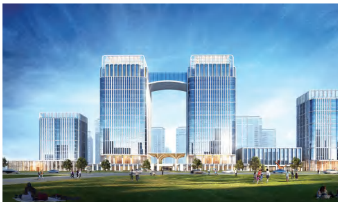
建工科技园（城建广场）项目
